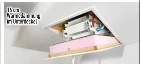
16 cm Wärmedämmung im Unterdeckel
